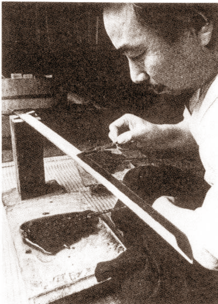
Fig.6 Tsuchioki , nakładanie mieszanki gliny i sproszkowanego węgla drzewnego na ostrze.
